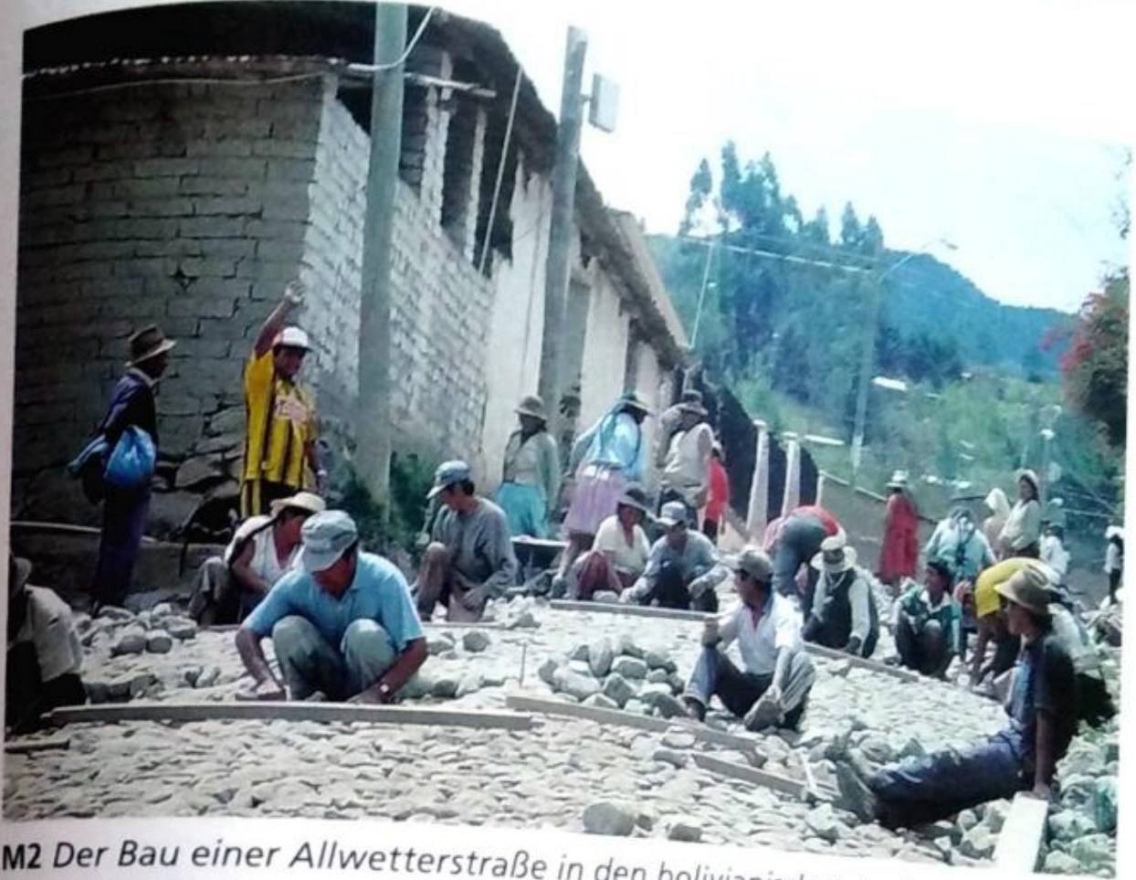
M2 Der Bau einer Allwetterstraße in den bolivianischen Anden ist eine Voraussetzung, dass die Bauern auf dem Wochenmarkt ihre Produkte verkaufen können.
