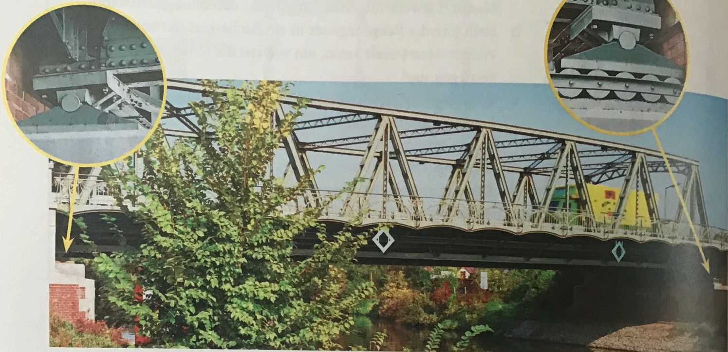
1 Brücke auf Rollen
